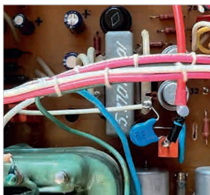
Рис. 3. Монтаж элементов D6, D7, C8, C10
